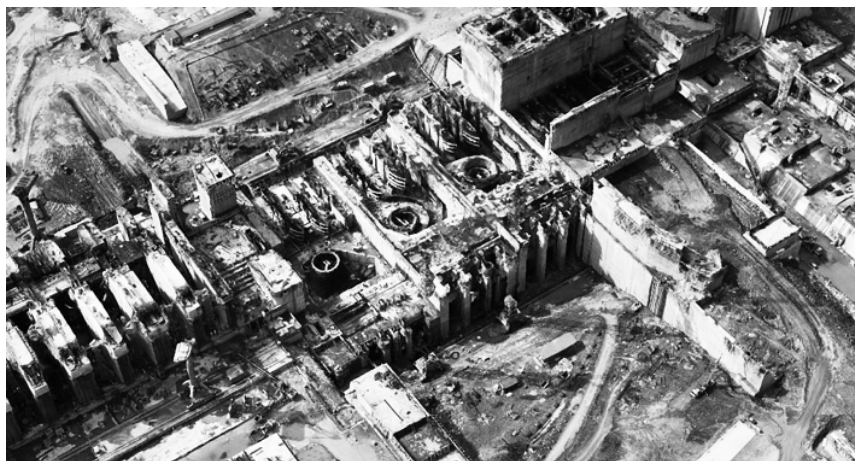
图1 重点施工区三维实景模型
