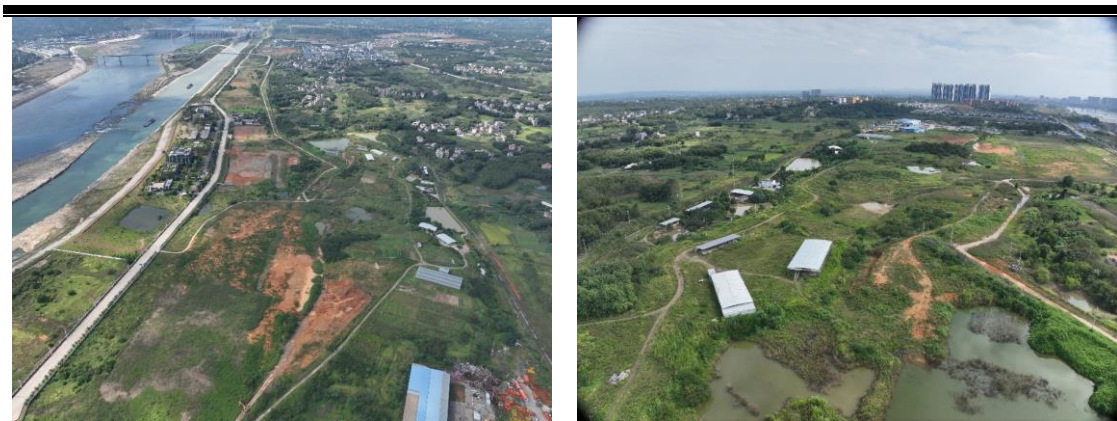
左岸表土暂存场现状
