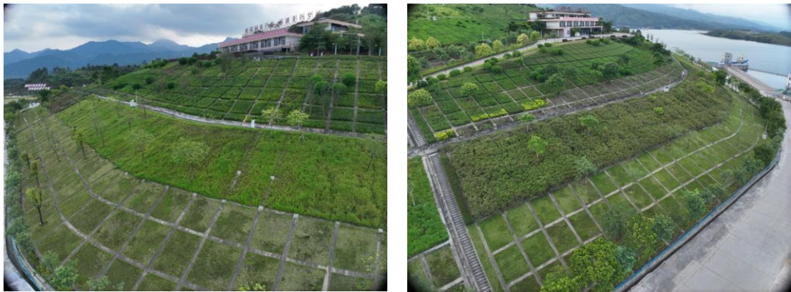
右岸框格梁植草护坡
