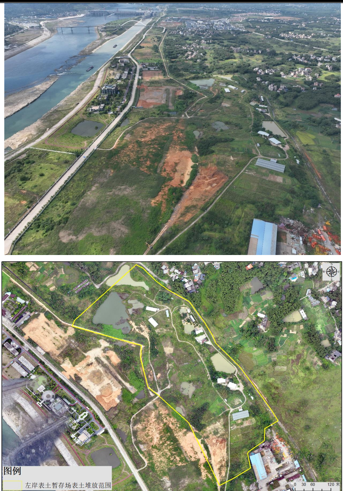
图 3-3 左岸表土堆存场无人机遥感现状图
