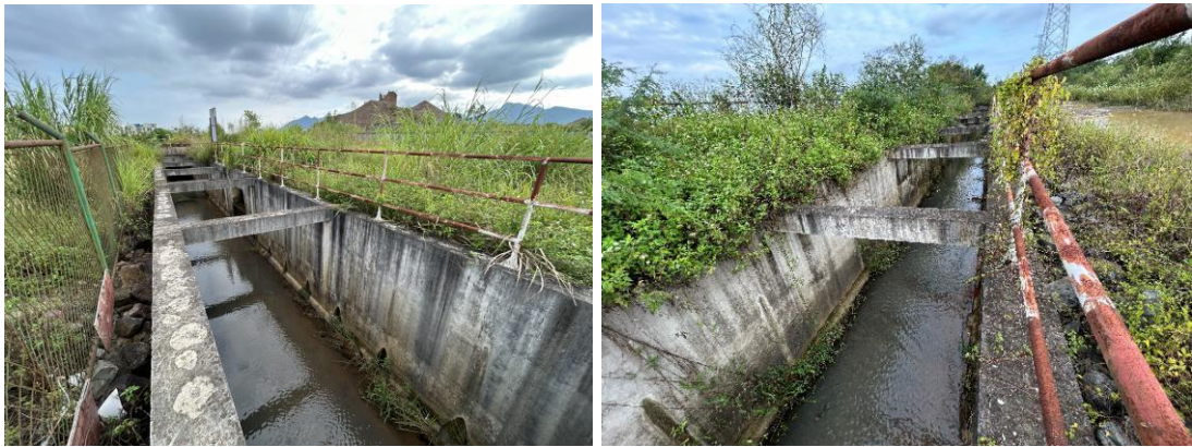
左岸排洪渠（左岸弃渣场附近）
