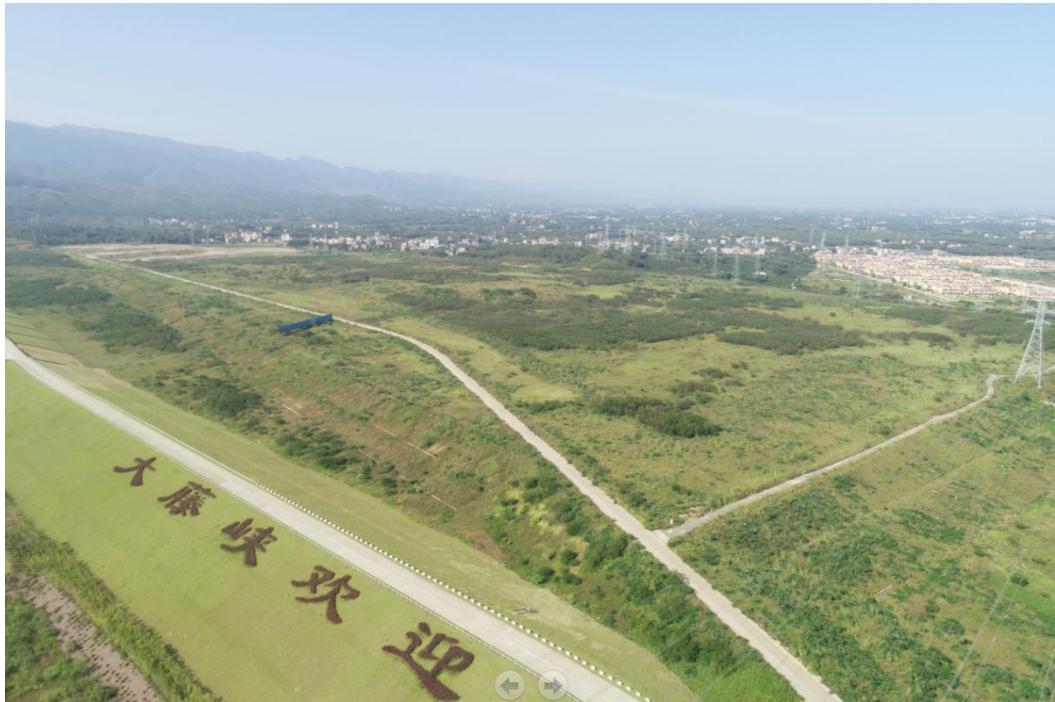
图 3.2-1 弃渣场航拍影像 (2023 年 10 月)
