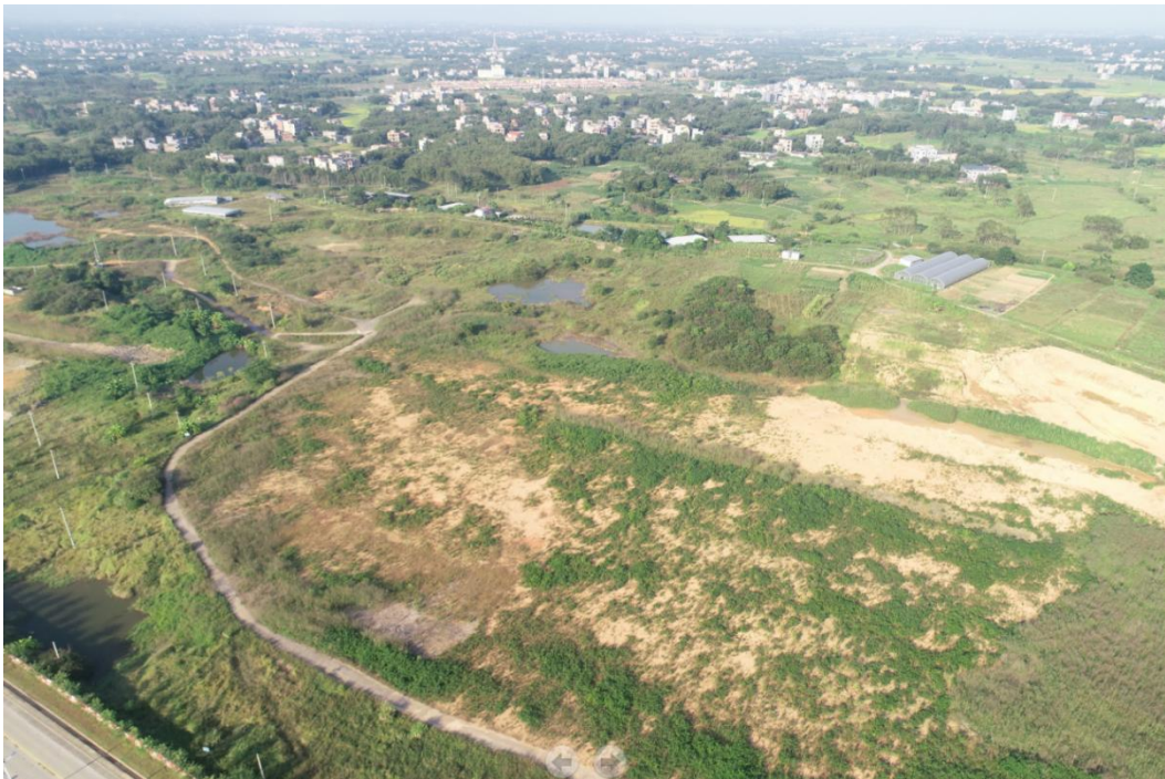
图 3.2-1 左岸表土堆存场现状(2023 年 10 月)
